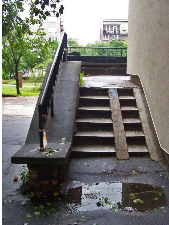
Fot. 4. Schody prowadzące na taras od strony al. Korfantego.
