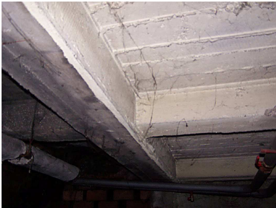
Fot. 11. Strop nad piwnicą – dobry stan techniczny.
